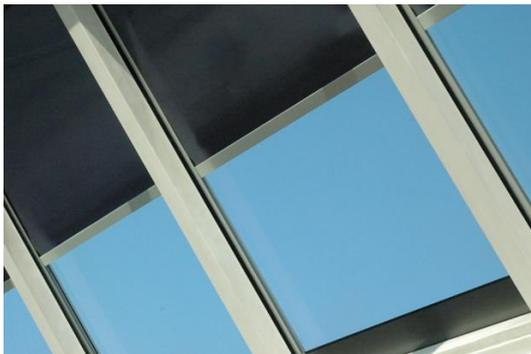
von 0° bis 90° Grad machen *ISO-Roll* zum Alleskönner – auch bei Modellscheiben wie: Parallelogramme, Dreiecke, Trapeze, schräge Kanten, uvm. Bei einem Gesamtenergie-durchlass bis zu 8% und mit seinen transparenten Eigenschaften lässt *ISO-Roll* den Blick nach außen zu. Die Hitze bleibt durch die Reflektion der Sonnenstrahlen draußen.
